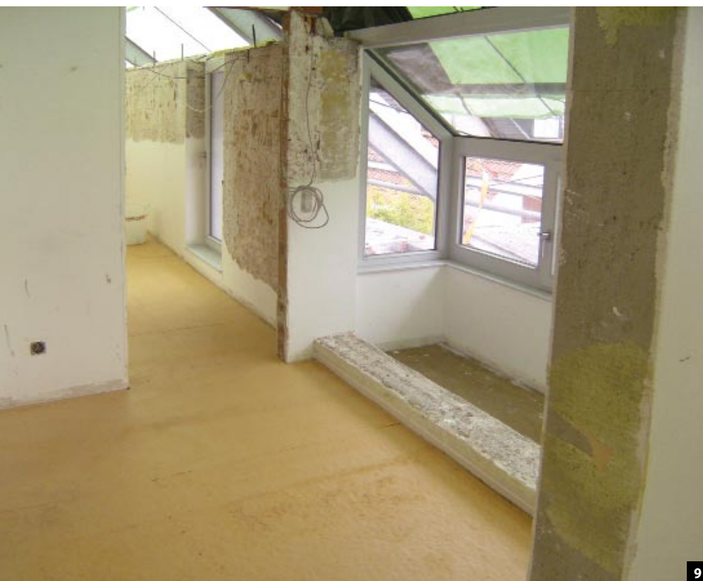
Abb. 9: Erst nach dem Rückbau des gesamten Dachgeschosses und der Entsorgung der befallenen Materialien konnte mit dem Neuaufbau begonnen werden.
