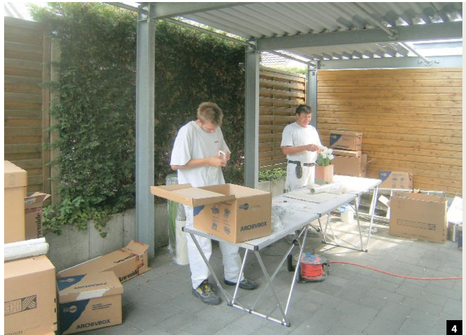
Abb. 4: Das gesamte Inventar der betroffenen Räume wurde einer Feinreinigung unterzogen.
